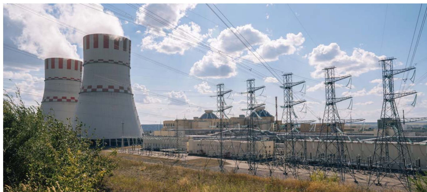
Нововоронежская АЭС. Фото – концерн «Росэнергоатом»
