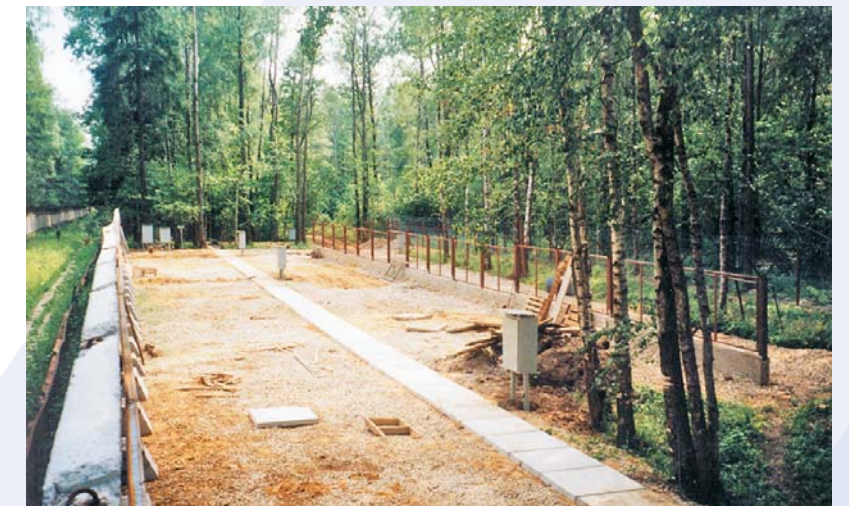
Строительство полигона инженерно-технических средств физической защиты российского производства
