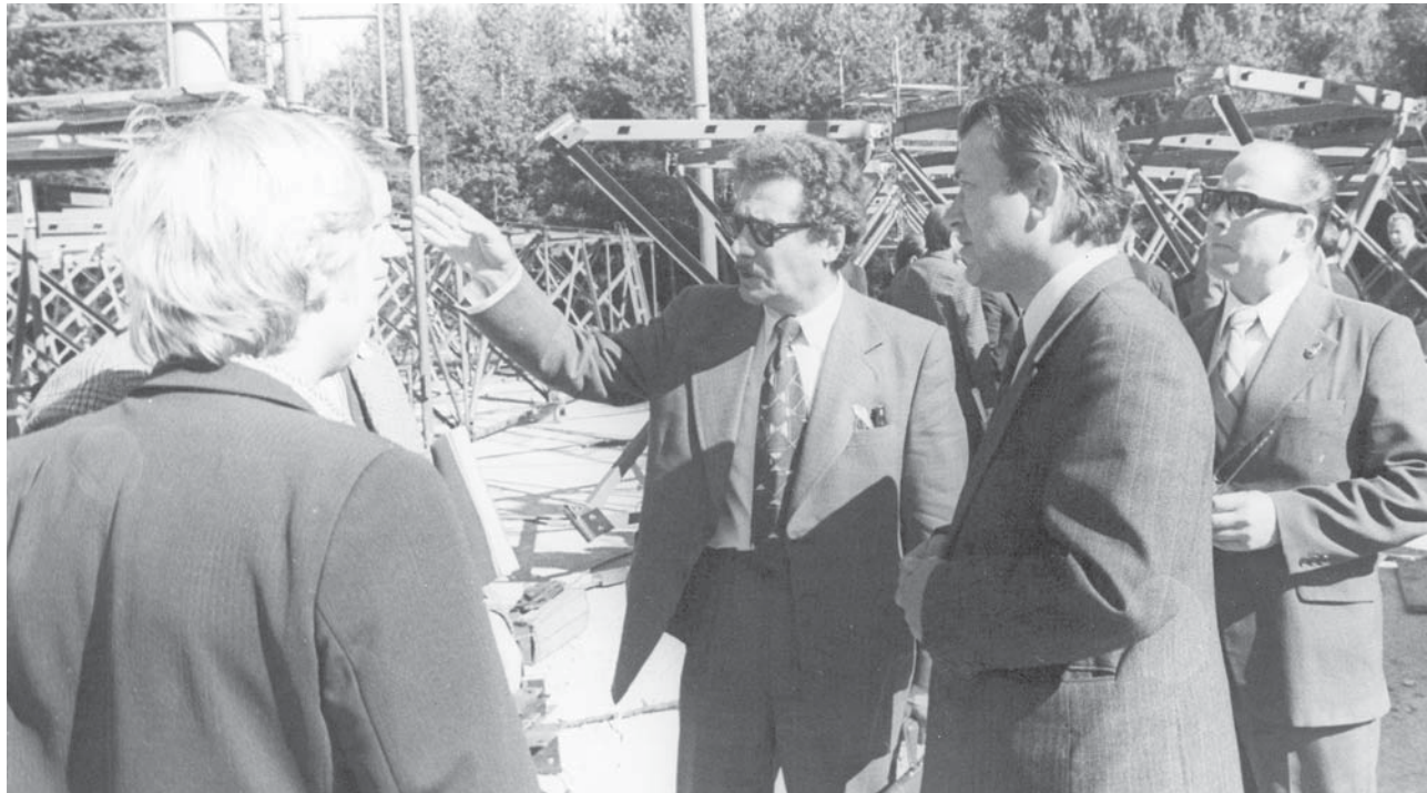
Обсуждение хода строительства павильона для отраслевой выставки
