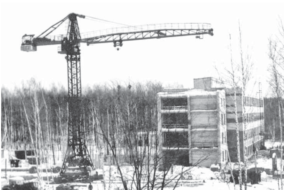
Строительство комплекса ЦИПК
